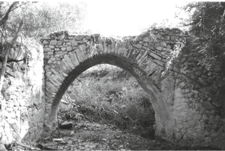
Puente del Mayorazgo sin reformar
